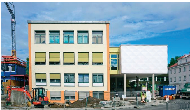
Der Anbau der Ludwig-Thoma-Schule wird zum neuen Schuljahr fertig sein.
