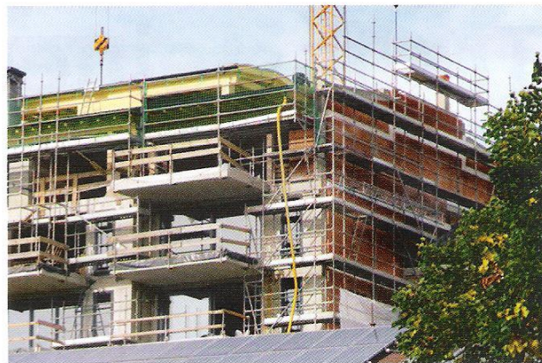
Erfreulich: auch in der Innenstadt entstehen neue Wohnungen ...
